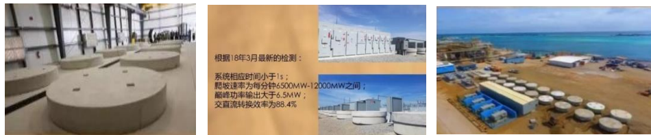
图 2 加拿大 Tempolar Power 公司有 3 个规模化应用项目
