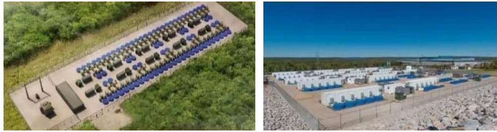
图 1 美国 Beacon Power 公司的两个 20MW 独立调频电站
